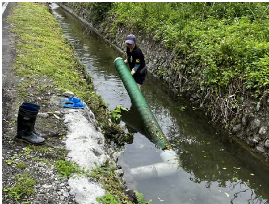
圖五 取水管易堆積汙物阻擋取水
