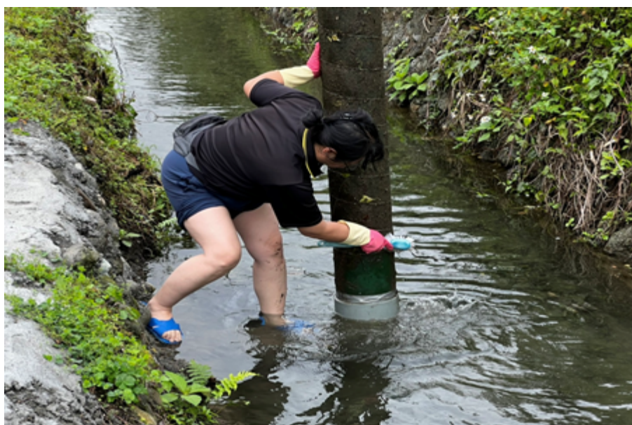
圖五 取水管易堆積汙物阻擋取水
